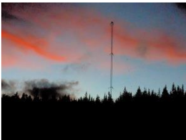
Antennemast John Craig (VO1NA)
