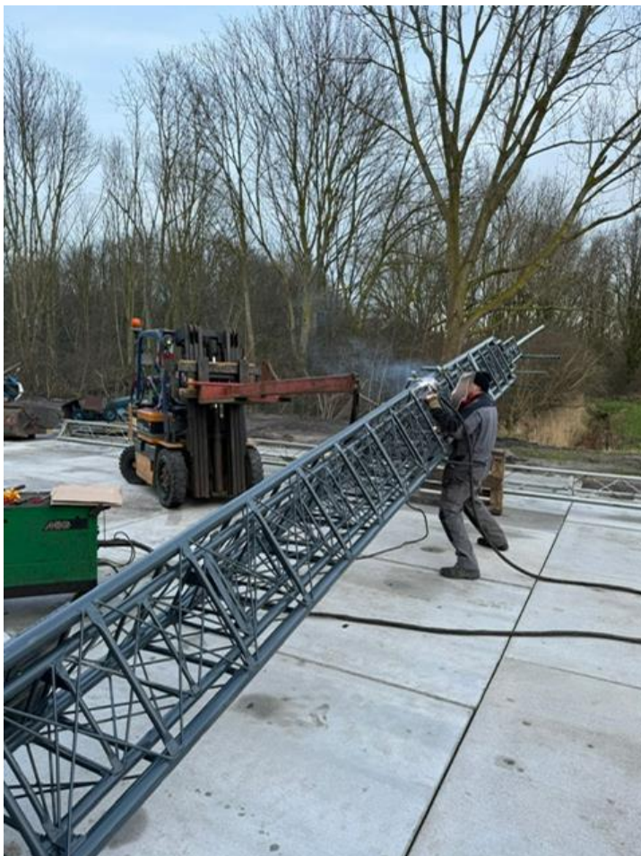
montage mast-bok aan fundering
