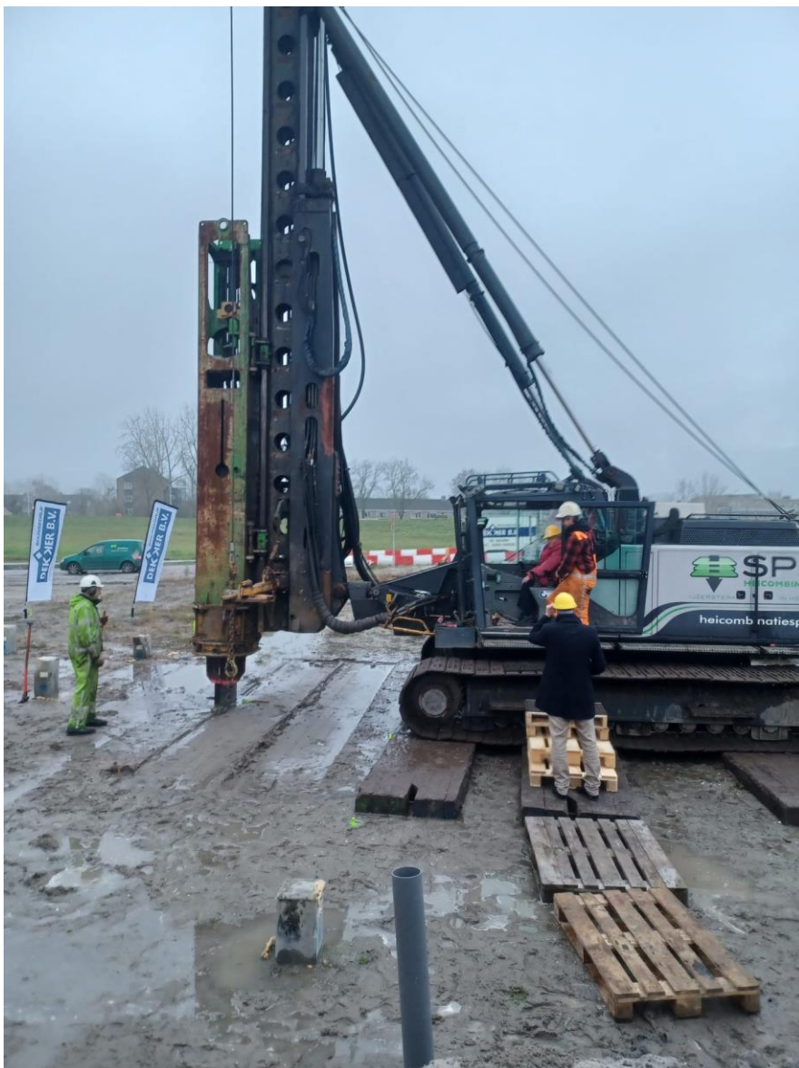
het heien voor de fundering in uitvoering
