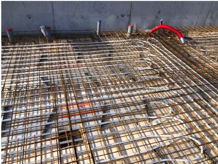
vlechtwerk van de fundering
