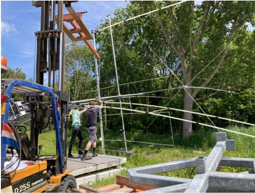
Montage van de antennes in de mast
